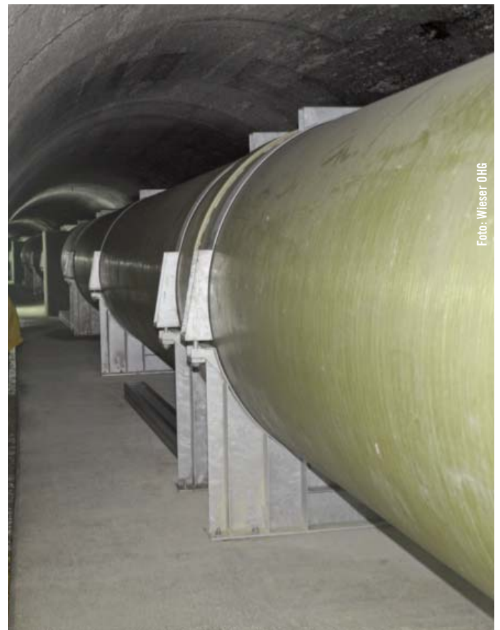
Auf speziellen Rohrsätteln verlegte das Team der Wieser OHG die Druckrohre im Rohrstollen, der mit einem Durchmesser von 3,9 m aus dem Berg gefräst wurde.
