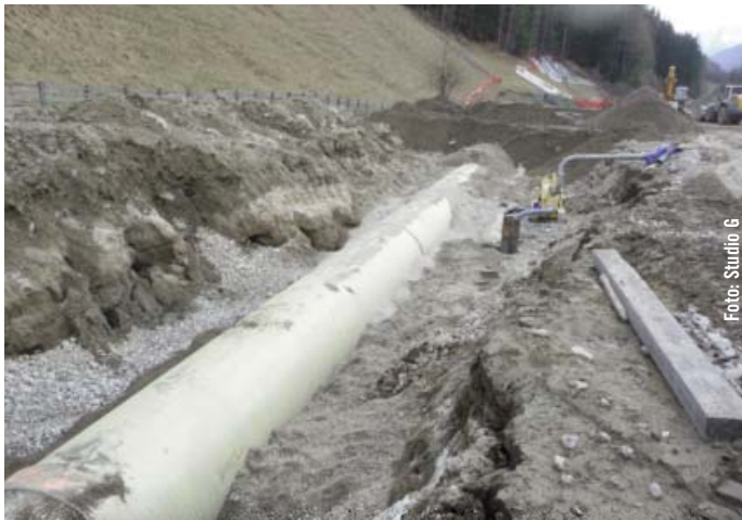
2 der insgesamt 3,4 Kilometer der Druckrohrleitung DN1800 für das neue Kraftwerk „In der Klamme“ wurden im Erdreich verlegt - der Rest in einem Felsstollen.
